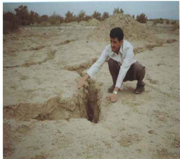
شکل 9. اختلاف ارتفاع ایجاد شده در دو طرف گسیختگی محیطی
